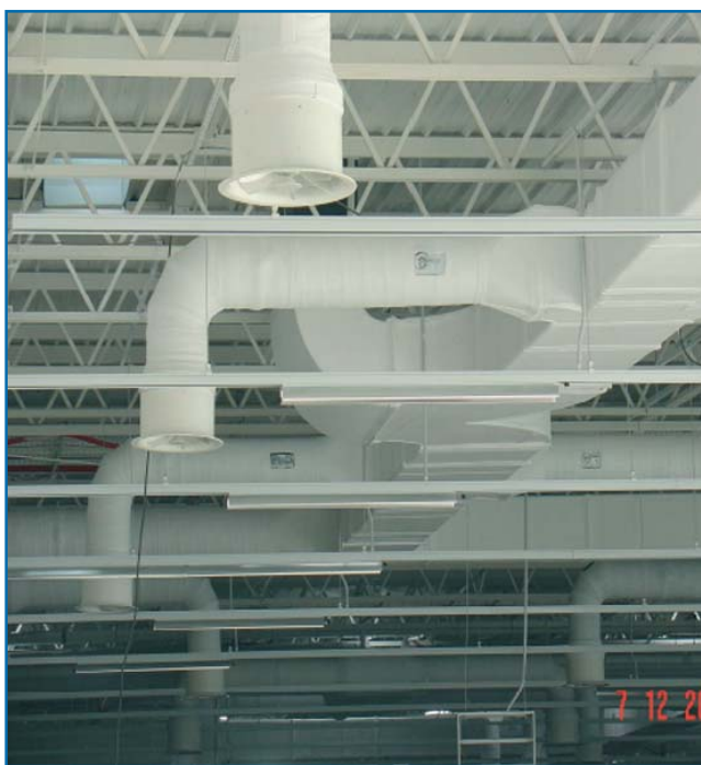
Ejemplo de difusor rotacional de geometría variable
